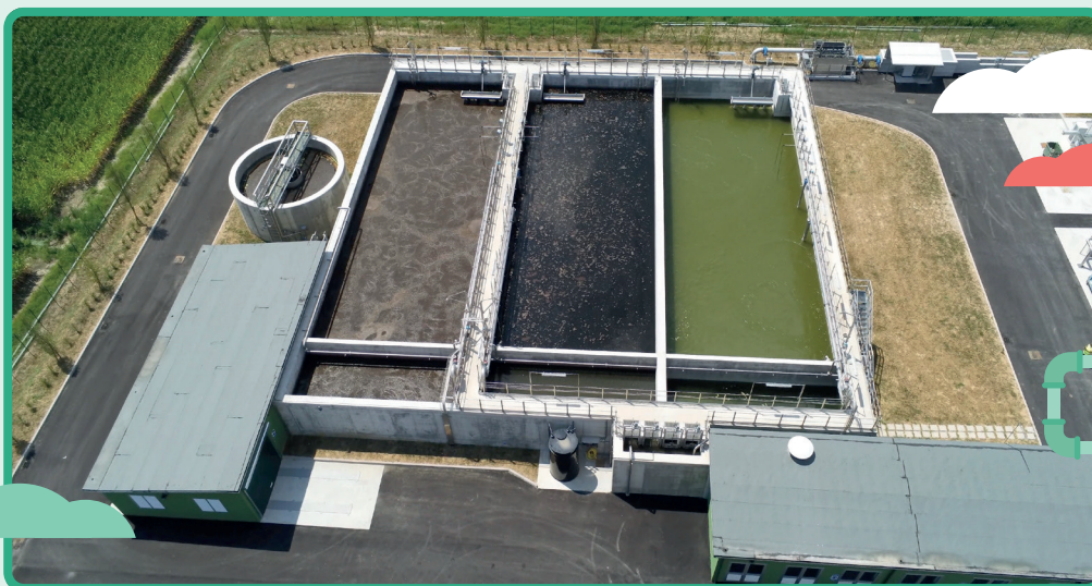
Nuovo depuratore di Isola della Scala in via Cà Magre.
