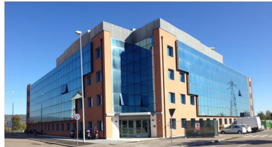
Figura 5-1: Immagine esterna dell’ingresso dell’immobile di via Gentilin, 71.
